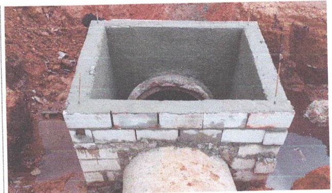
Localização Serviços Rua Benedito Bonifacio (ramificação da Rua Antonio Marques) - BAIRRO SANTA CRUZ TRABALHOS EM TERRA (CONFEÇÃO DA DRENAGEM)
